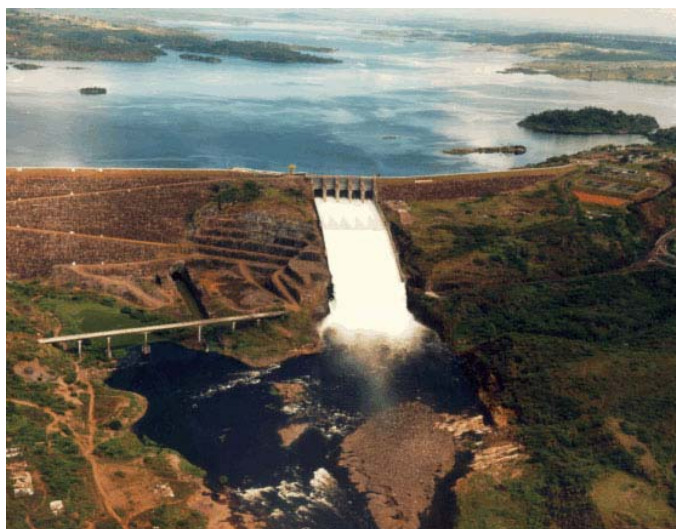
Figura 3.5 Vista da barragem Pedra do Cavalo (CBDB, 2004).
